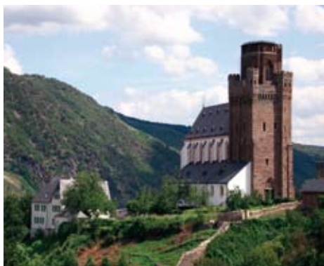
Blick auf St. Martin und das benachbarte Pfarrhaus der Pfarrei Oberwesel
